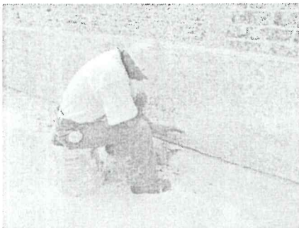
Nuestro personal finaliza la limpieza del residuo de manto asfáltico e iniciar el trazo para la colocación de la baldosa de barro
