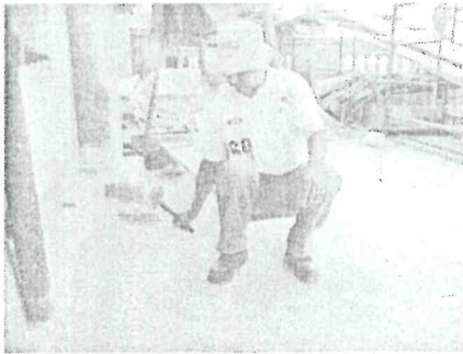
Limpieza efectuada con hachuelas, es un proceso lento para no lastimar la losa
